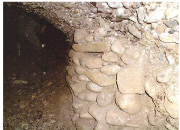
Eine kompakte Trockenmauer hält das Sediment im Nebentunnel zurück1.
